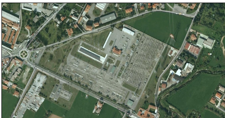
La sottostazione di Gorlago (immagine Google)
