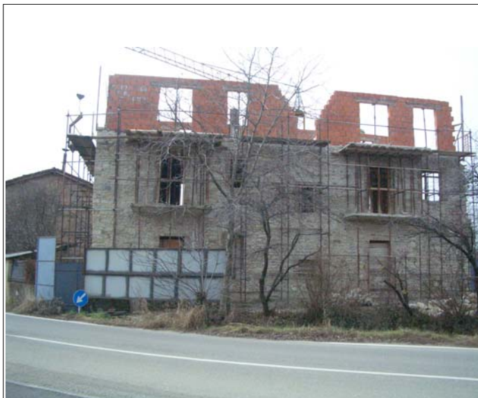
Corpo C fronte nord
