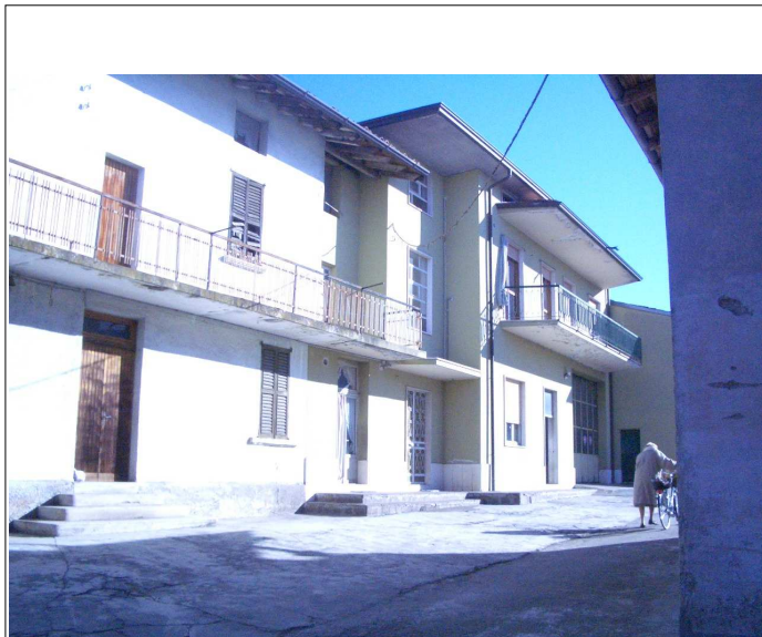
Corpo A fronte sud
