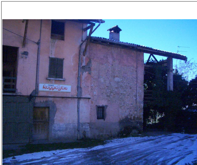
Corpo A e B fronte nord
