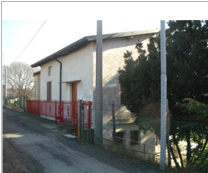
Corpo A fronte ovest
