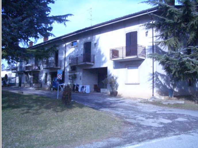
Corpo A fronte sud
