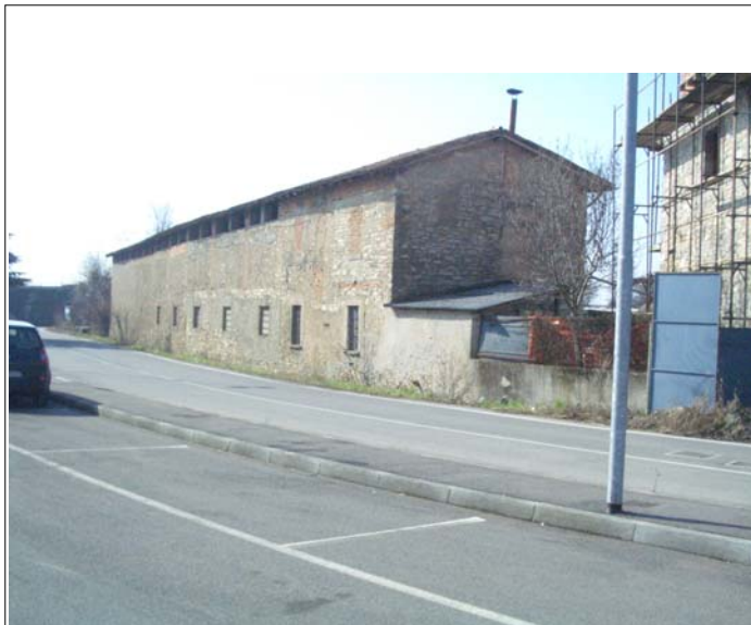
Corpo A e B fronte est
