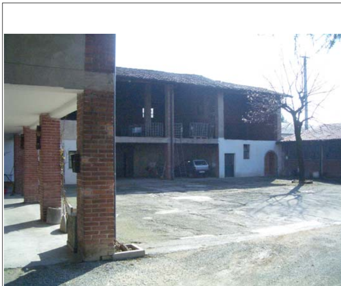
Corpo C fronte ovest
