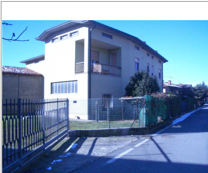
Corpo A scorcio fronti nord e est e corpo C
