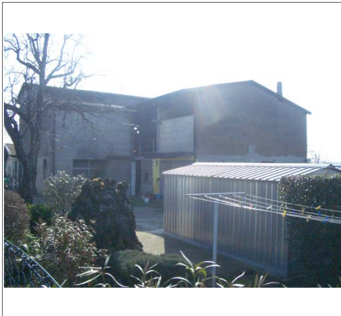
Corpo C fronte ovest
