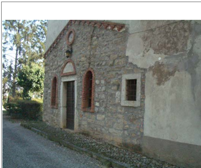
Corpo A fronte ovest
