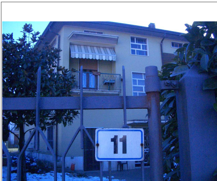
Corpo A fronte ovest
