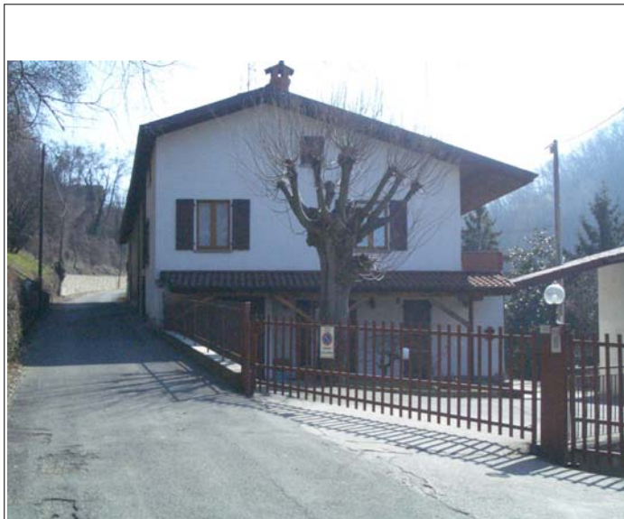
Corpo A fronte ovest e a destra corpo B
