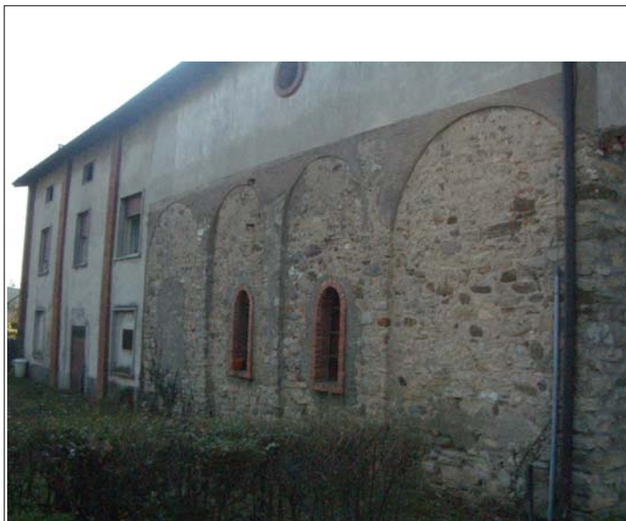
Corpo A e B fronte nord
