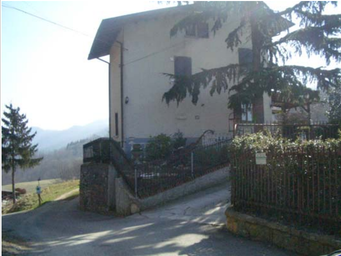
Corpo A fronte ovest
