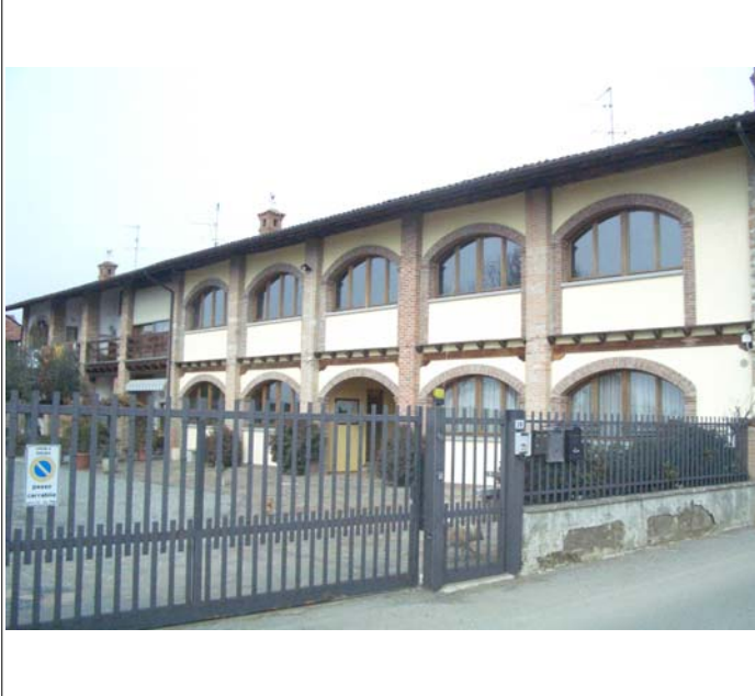
Corpo A fronte sud
