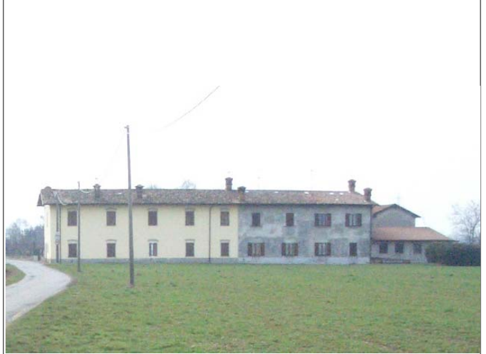
Corpo A e B fronte nord
