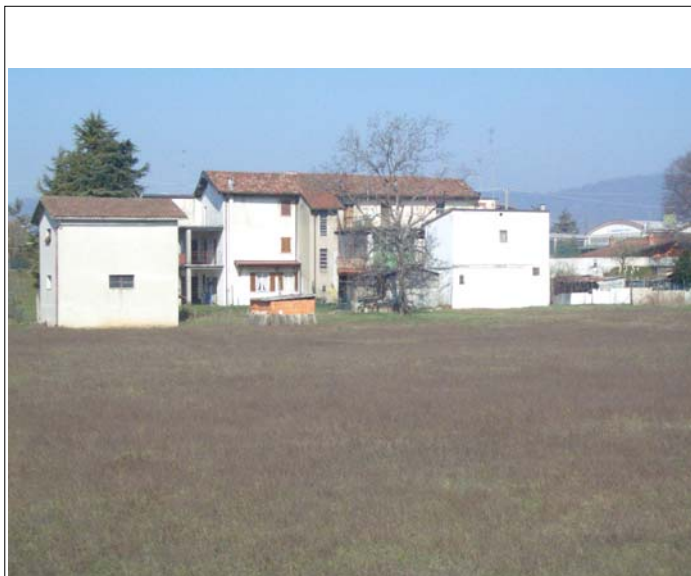
Corpo A e B fronte est
