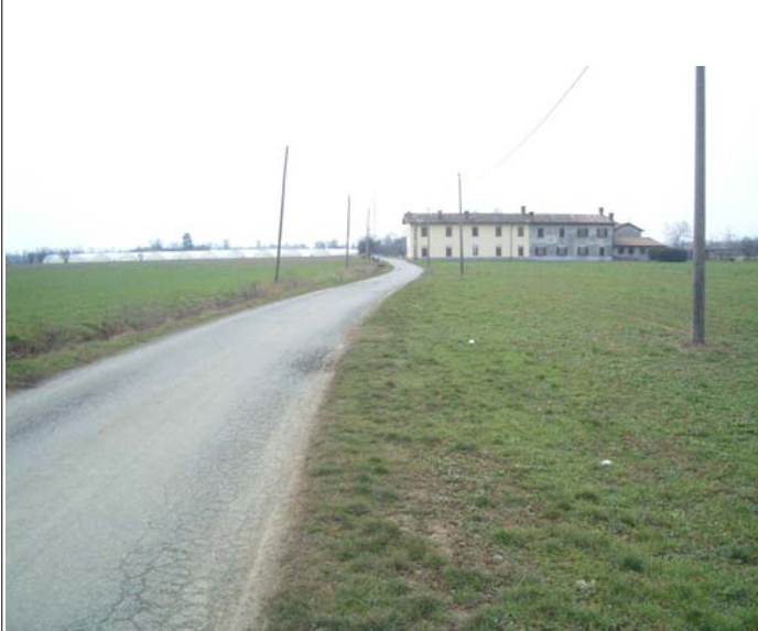
Corpo A e B fronte nord
