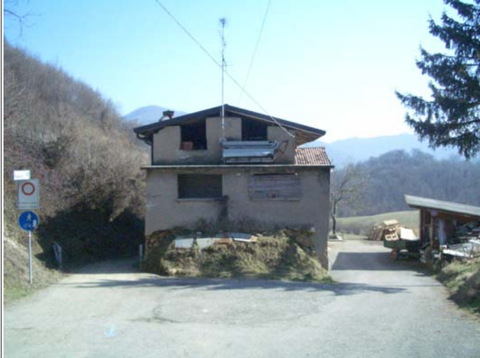
Corpo A fronte ovest
