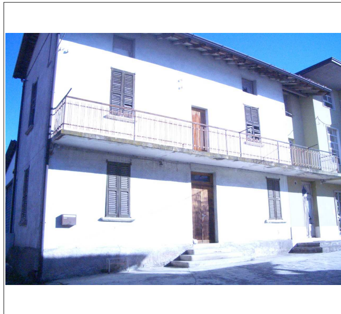
Corpo A fronte sud
