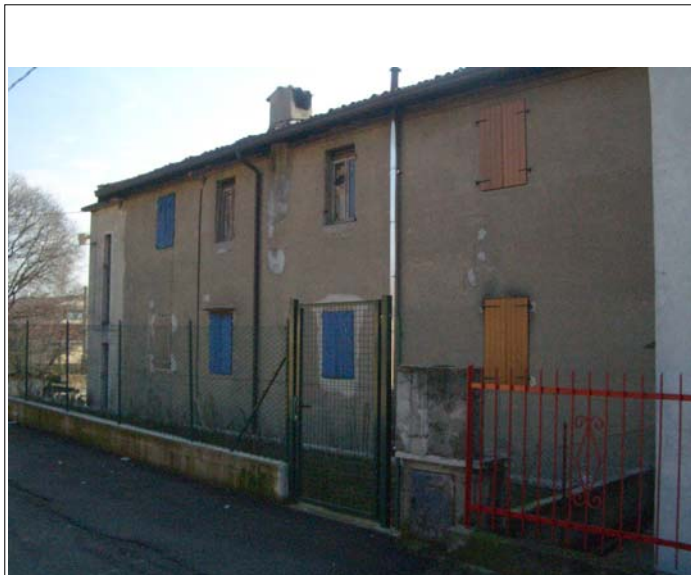
Corpo A fronte ovest
