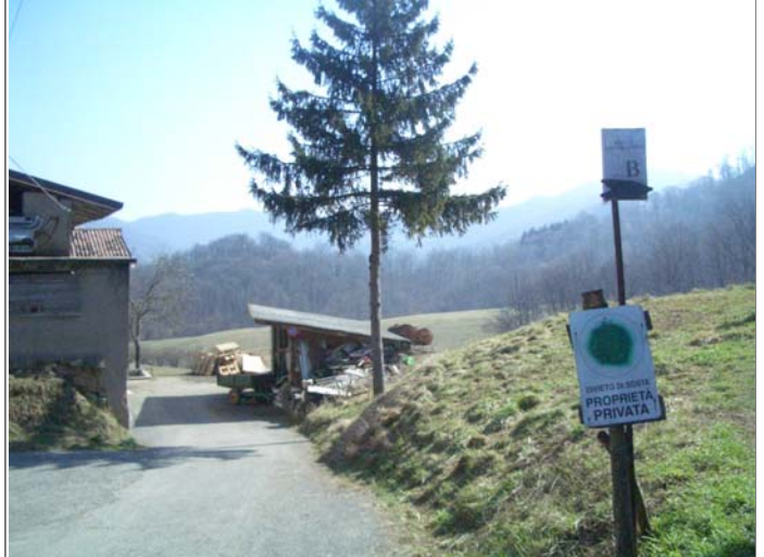
Corpo C fronte ovest
