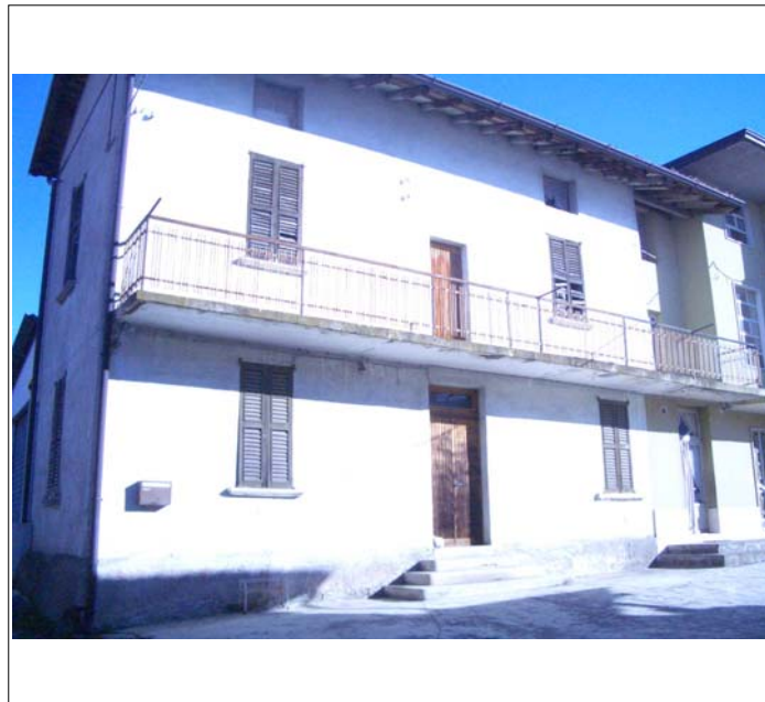
Corpo A fronte sud
