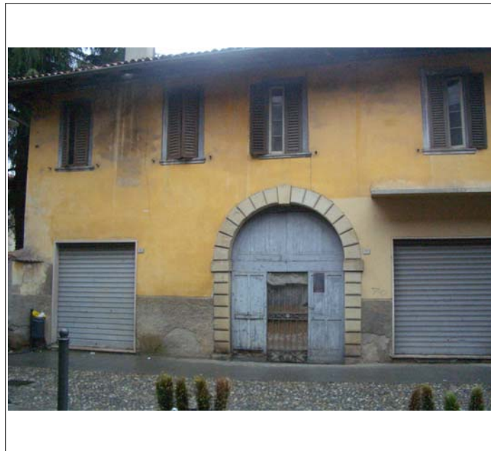
Corpo A fronte su strada
