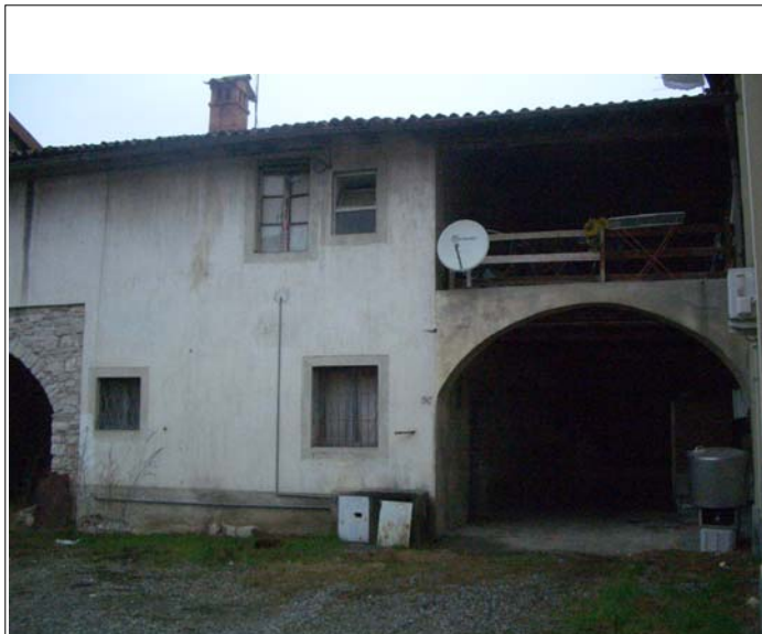
Corpo A fronte sud
