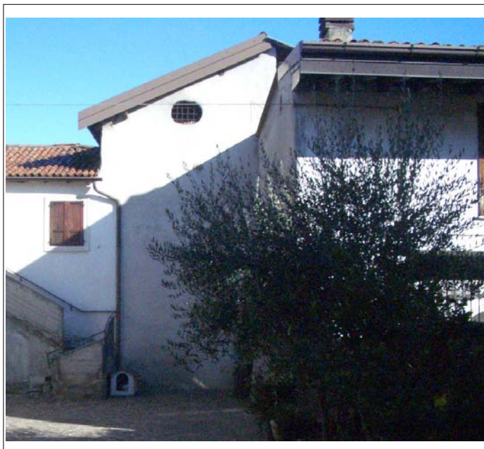
Corpo A fronte sud
