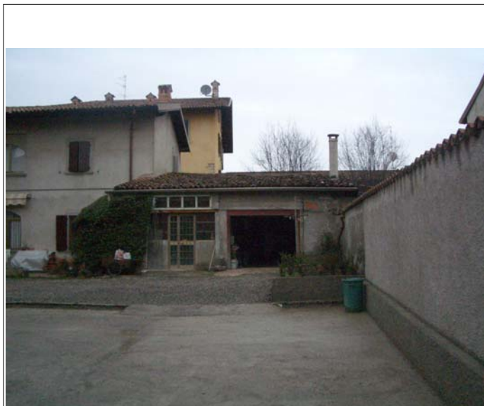
Corpo B fronte sud
