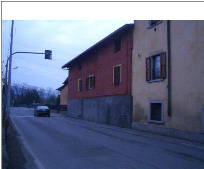
Corpo A fronte nord su strada
