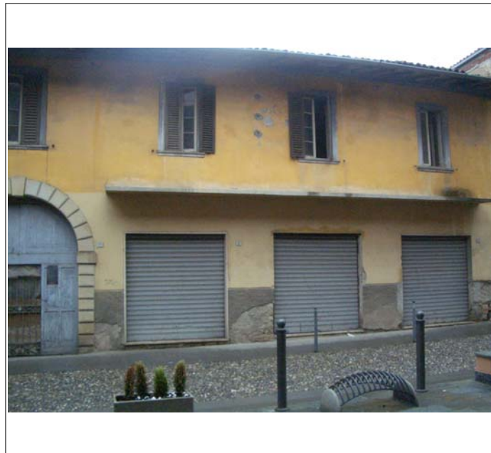
Corpo A fronte su strada
