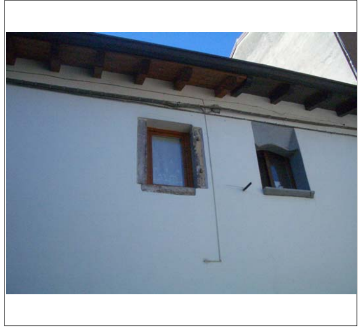
Corpo A particolare fronte nord
