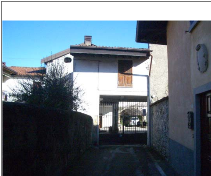
Corpo B ingresso, fronte sud
