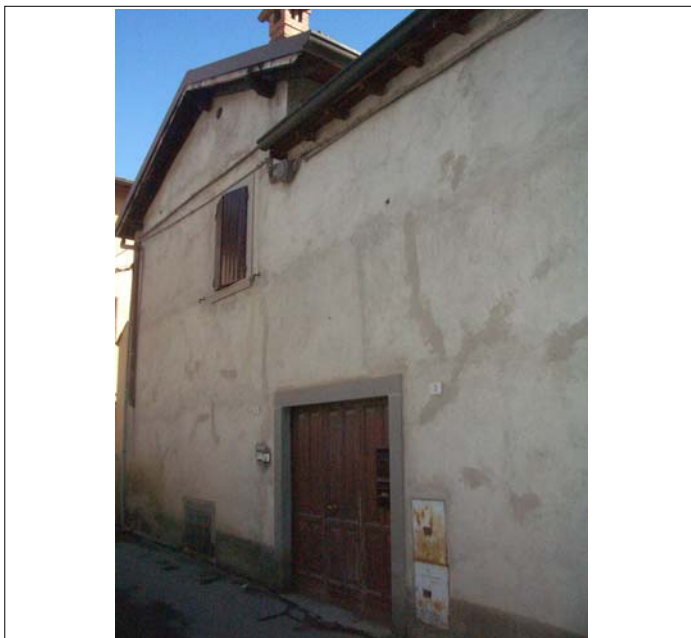
Corpo A fronte su strada
