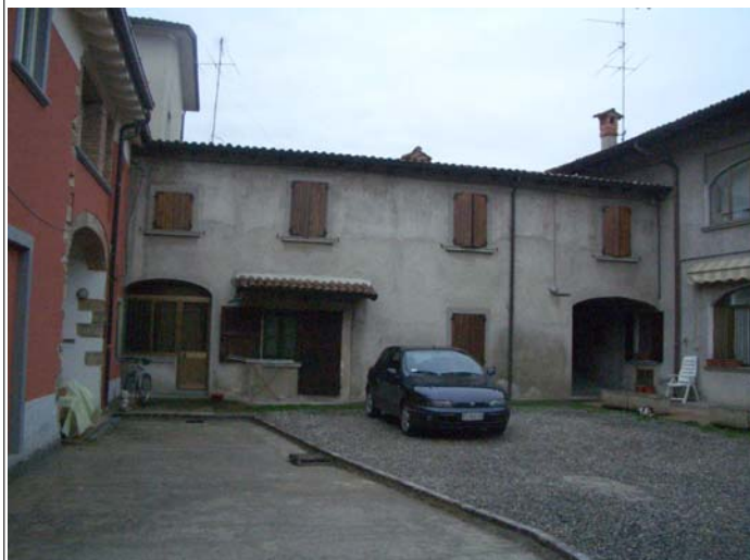
Corpo A fronte interno (est)
