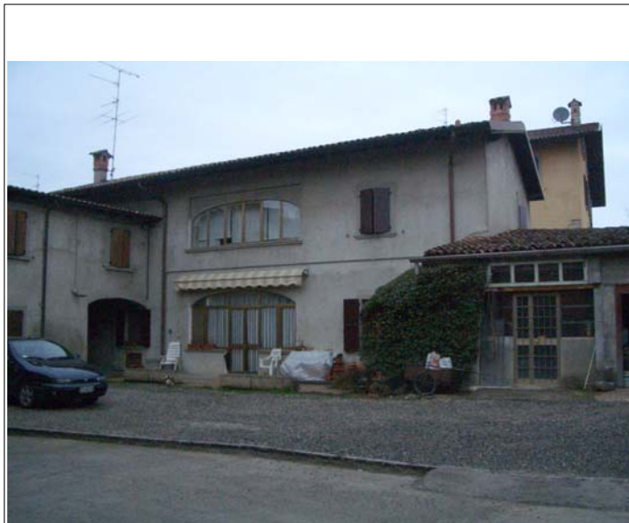
Corpo A fronte sud
