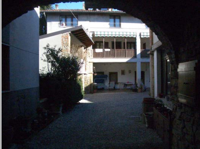
Corpo A fronte sud e scorcio corpo B
