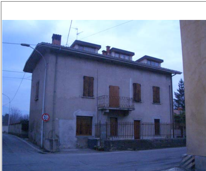
Corpo A scorcio fronte sud e ovest
