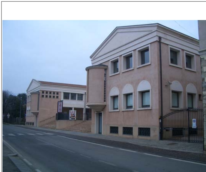
Corpo A fronte su strada
