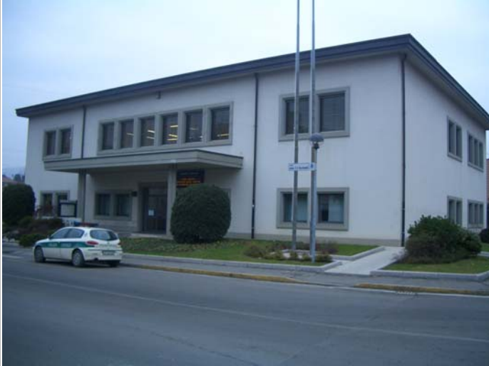
Corpo A fronte sud e scorcio fronte est
