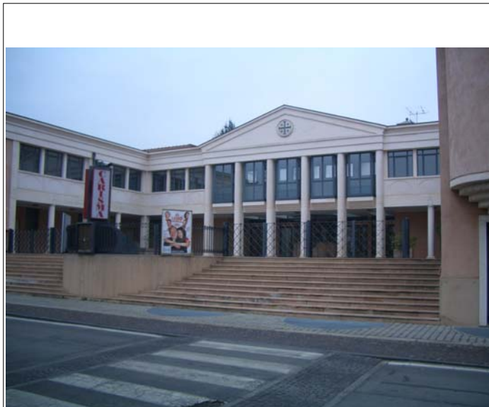
Corpo A fronte su strada
