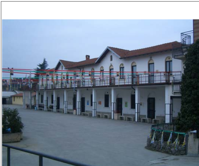
Corpo A fronte sud e sullo sfondo a sinistra Corpo D
