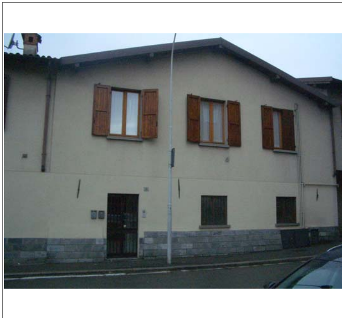
Corpo A fronte su strada
