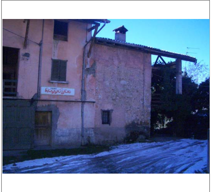
Corpo A e B fronte nord
