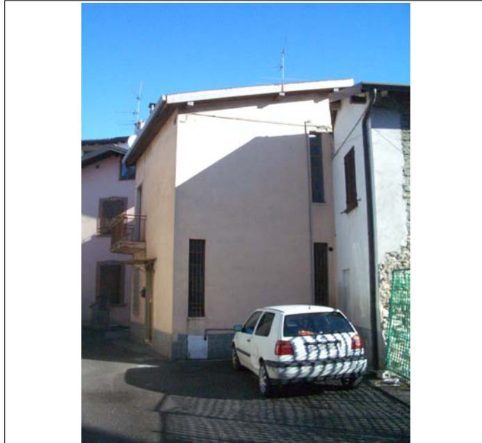
Corpo A fronte sud
