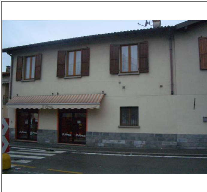
Corpo A fronte su strada
