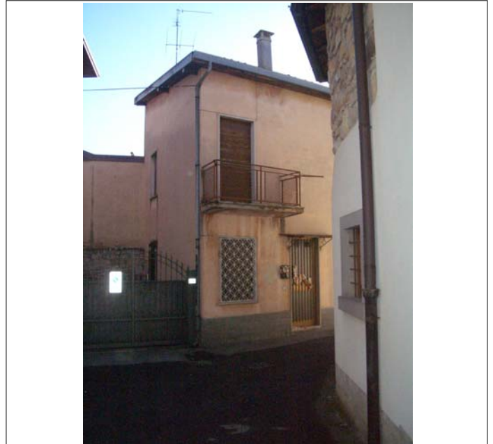
Corpo A fronte ovest
