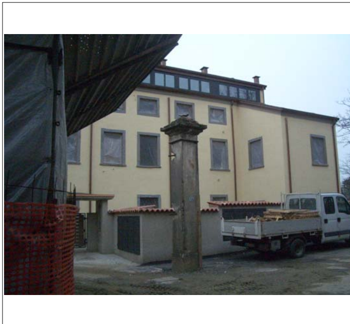
Corpo A scorcio fronte nord
