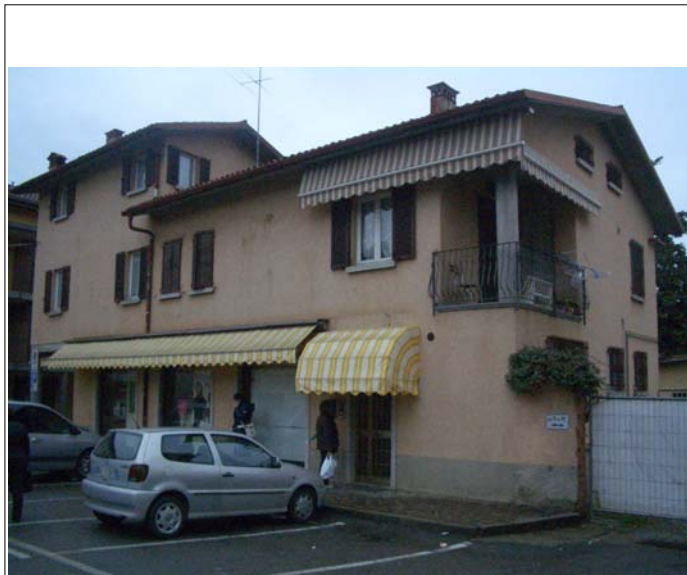
Corpo B fronte sulla piazza
