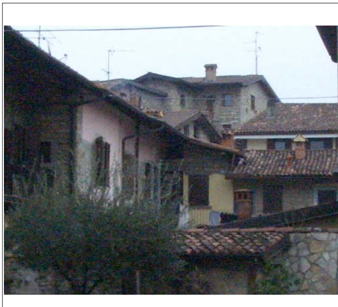
Corpo A sulla sinistra scorcio del fronte interno a sud
