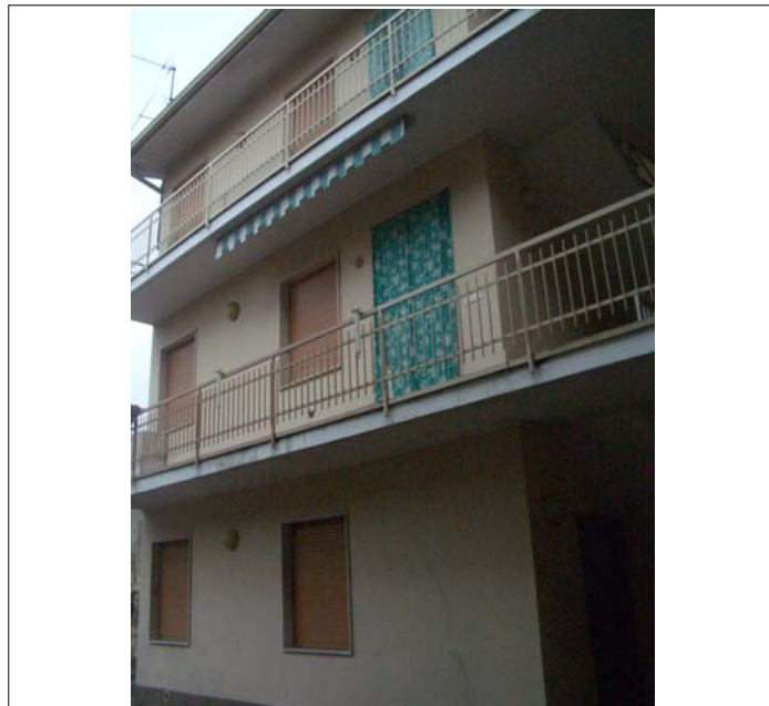
Corpo A scorcio fronte sud
