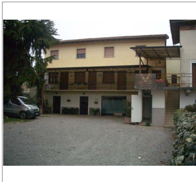
Corpo A fronte sud
