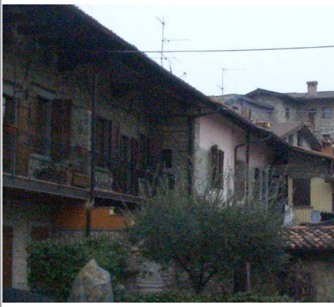
Corpo A scorcio fronte sud
