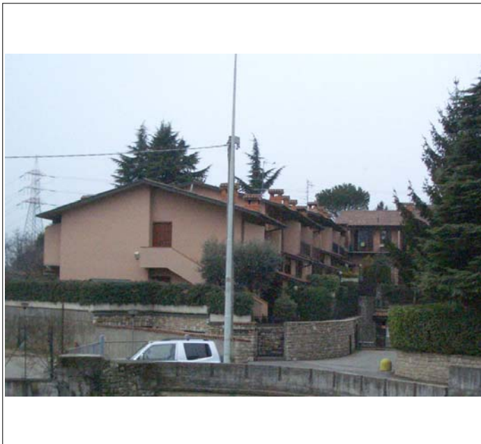
Corpo A vista da est
