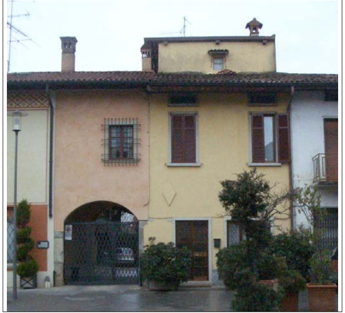
Corpo A e corpo B: fronte est
