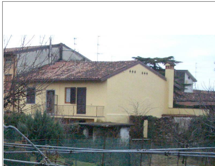
Corpo A e B fronte nord
