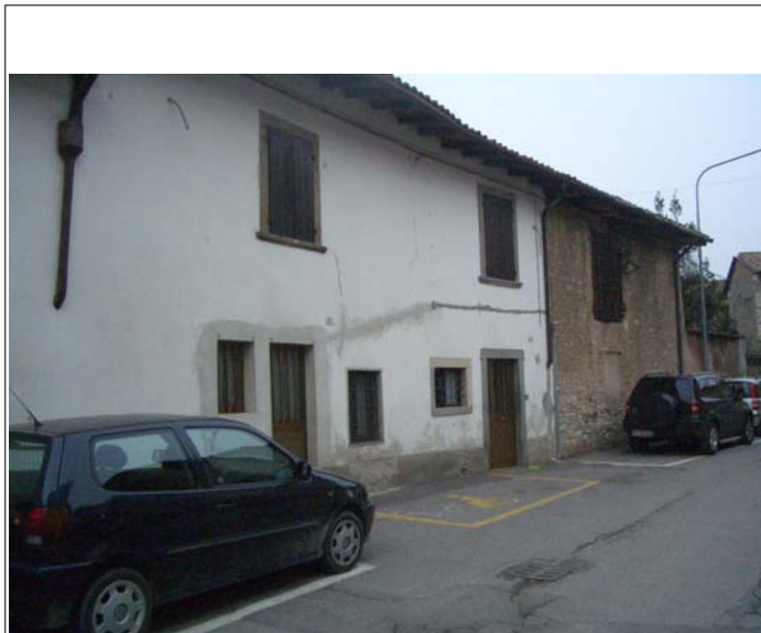
Corpo A fronte su strada
