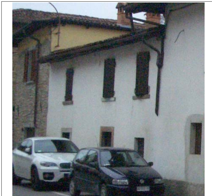
Corpo A fronte su strada
