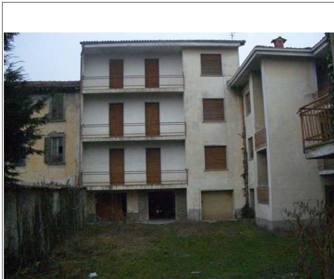
Corpo A fronte sud e scorcio del fronte ovest del corpo B
