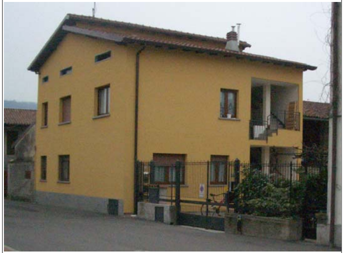
Corpo A fronte su strada
