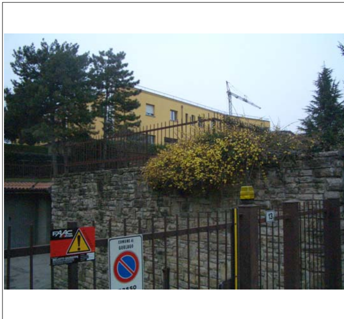
Corpo A vista da est
