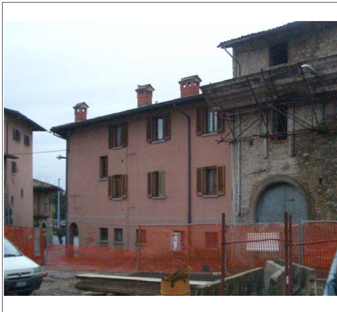
Corpo A fronte nord-est
