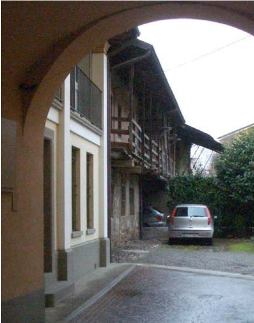
Corpo A sullo sfondo a sinistra scorcio fronte nord
