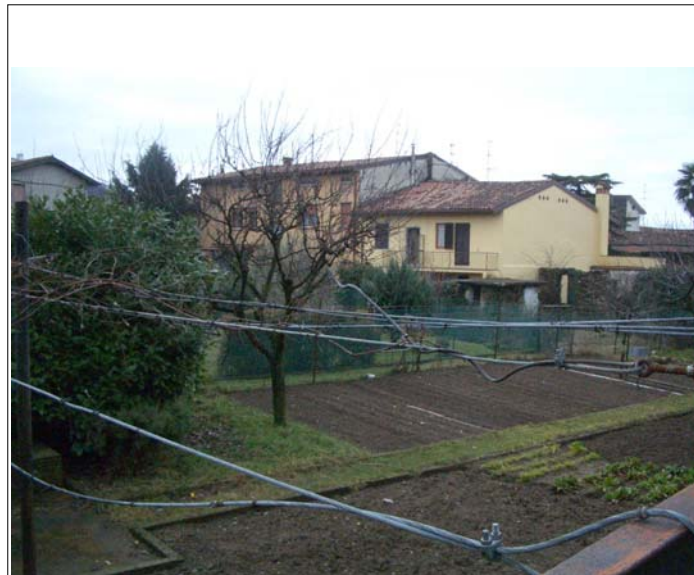
Corpo A e B fronte nord
