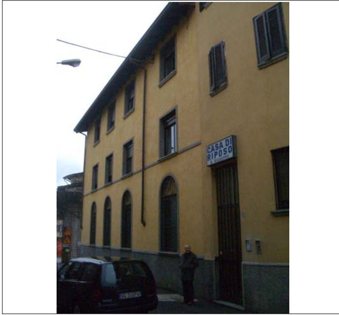
Corpo A fronte su strada
