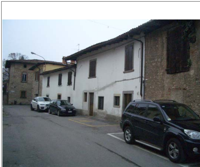
Corpo A fronte su strada
