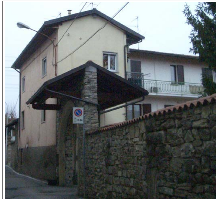
Corpo E fronte su strada
