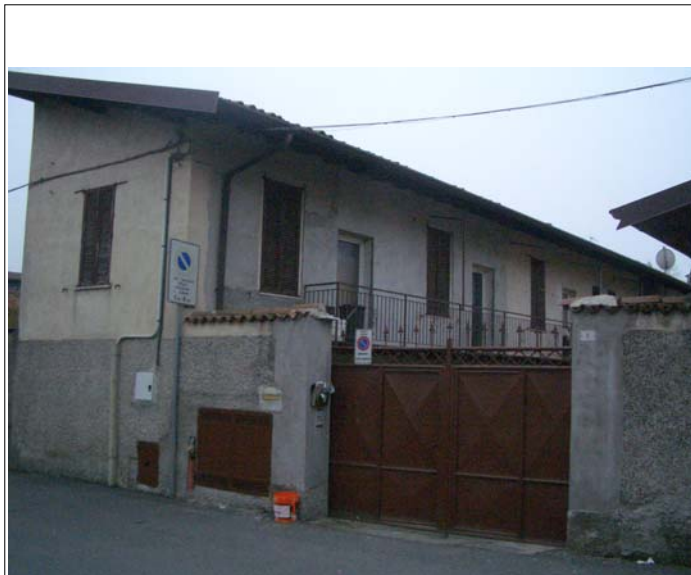
Corpo A vista dalla strada
