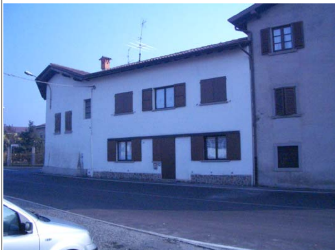
Corpo A fronte su strada (ovest)
