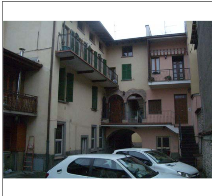
Corpo A fronte interno
