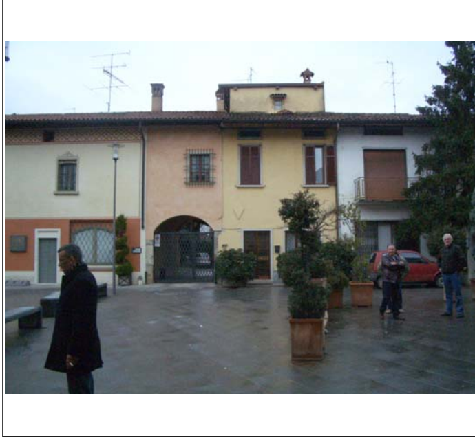
Corpo A e corpo B: fronte est
