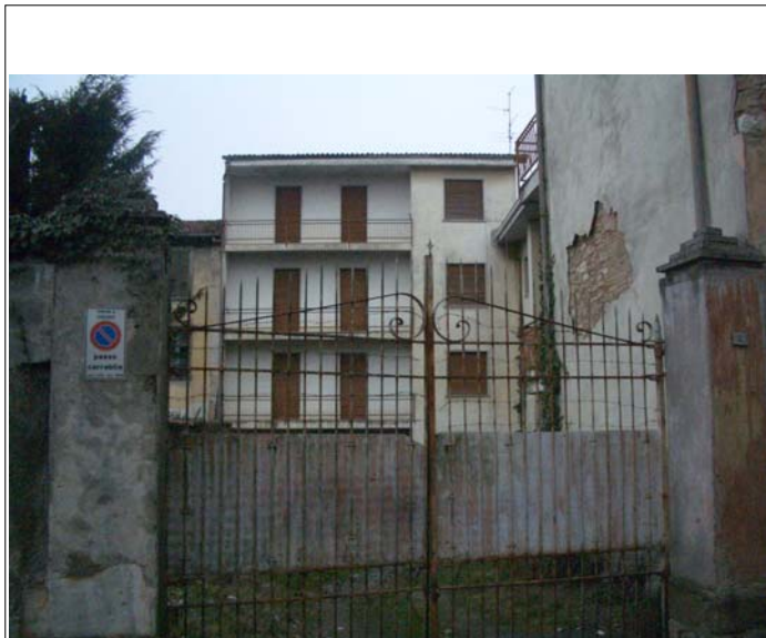
Corpo A fronte sud
