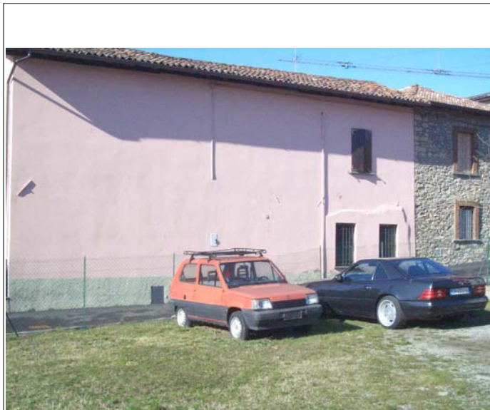
Corpo A fronte nord-est
