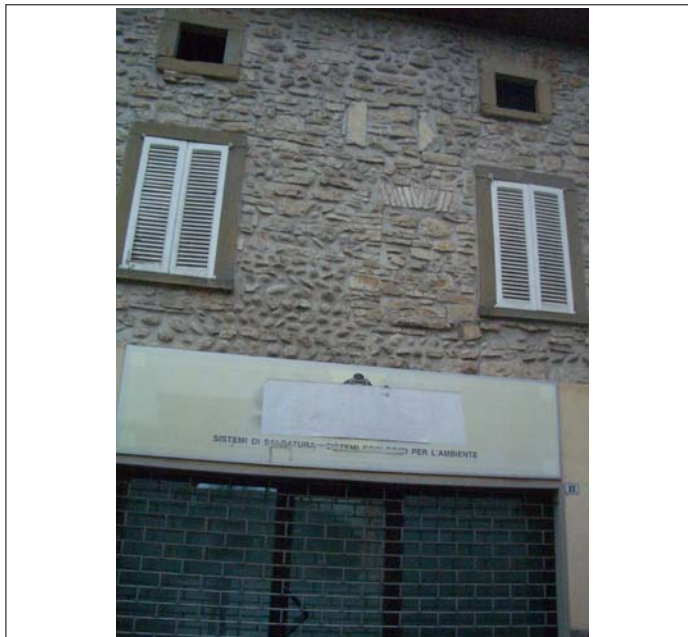
Corpo A particolare fronte su strada
