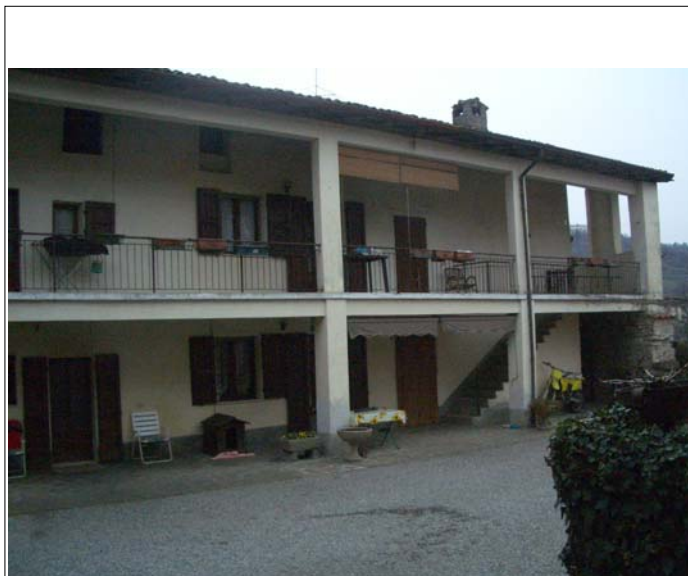
Corpo A prospetto sud-est
