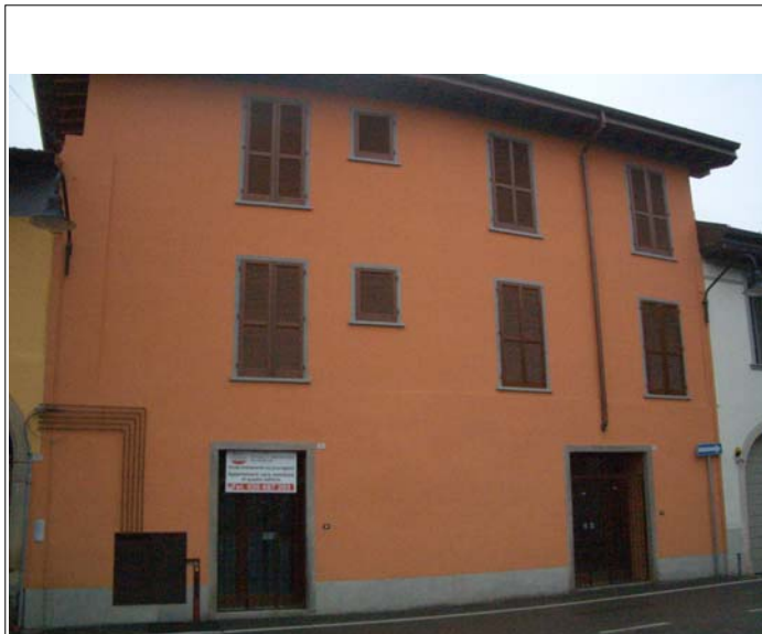
Corpo A facciata sulla piazza
