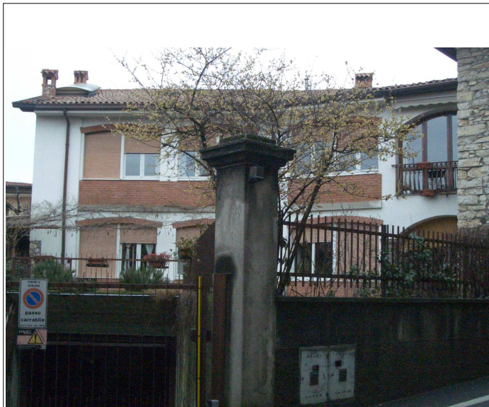
Corpo A fronte sud
