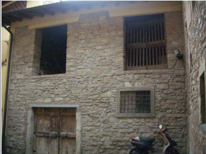
Corpo A fronte ovest
