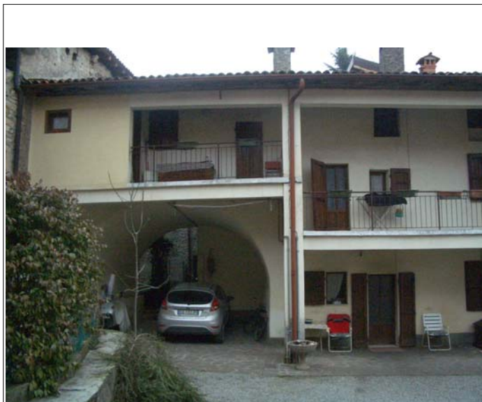
Corpo A prospetto sud-est
