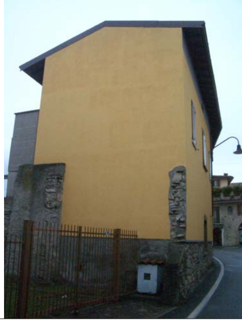
Corpo A fronte sud
