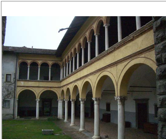
Corpo A fronte interno prospetti nord-est esud-est
