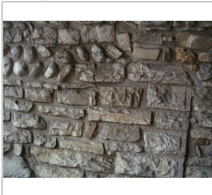
Corpo A particolare tessitura muraria nell'androne
