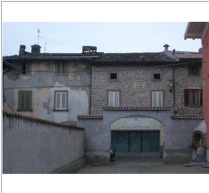
Corpo A fronte su strada
