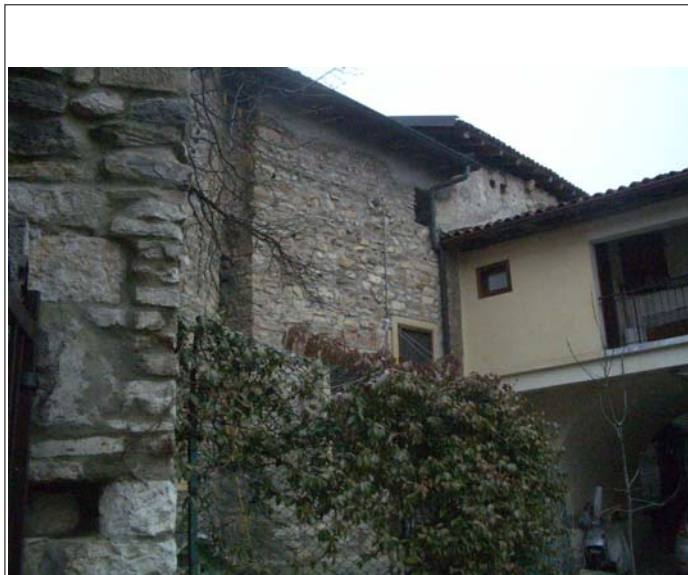
Corpo B fronte sud-est
