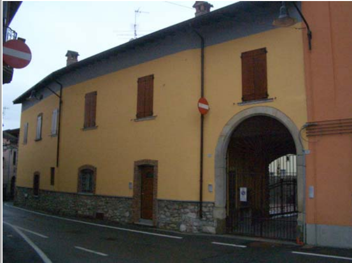
Corpo A fronte su strada
