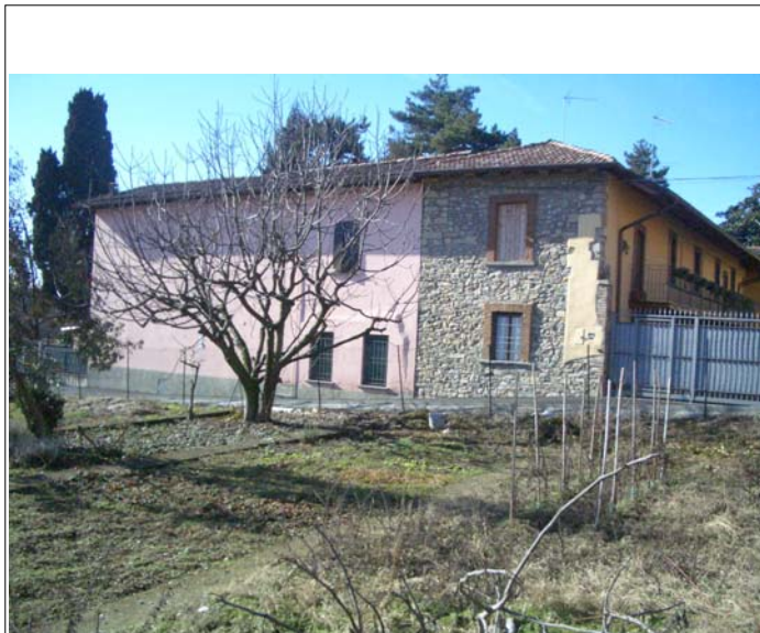
Corpo A fronte su strada (nord-est)
