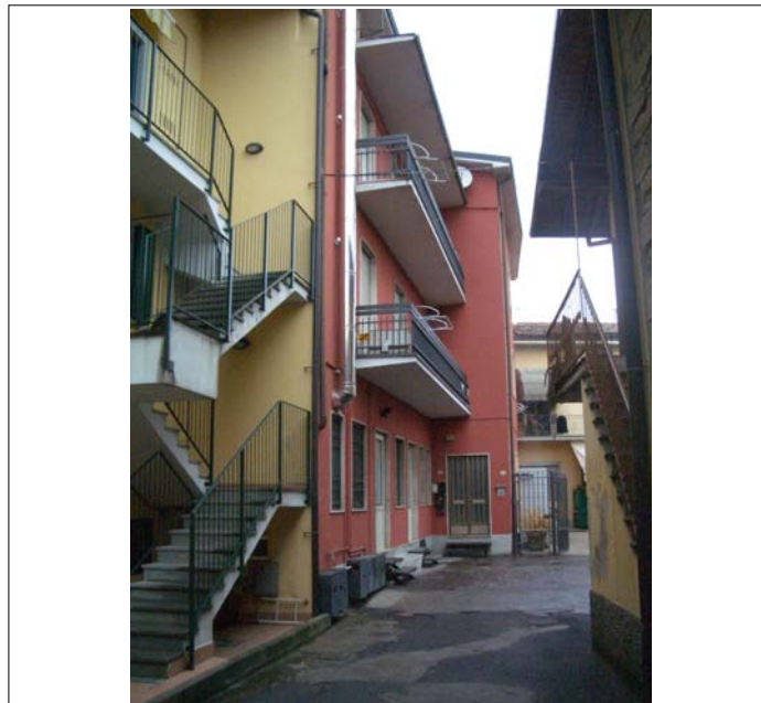
Corpo A fronte interno
