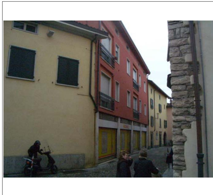
Corpo A fronte su strada
