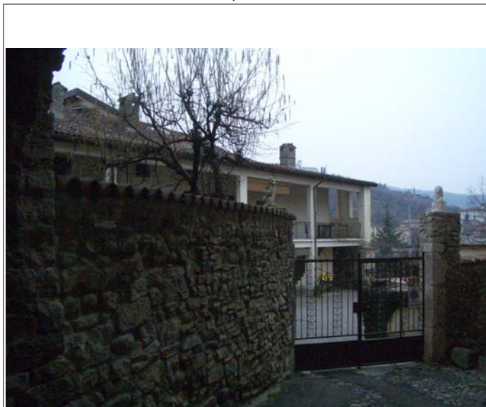
Corpo A il muro di cinta in pietra
