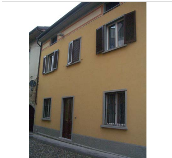
Corpo A fronte su strada
