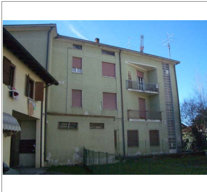
Corpo A retro (fronte nord)
