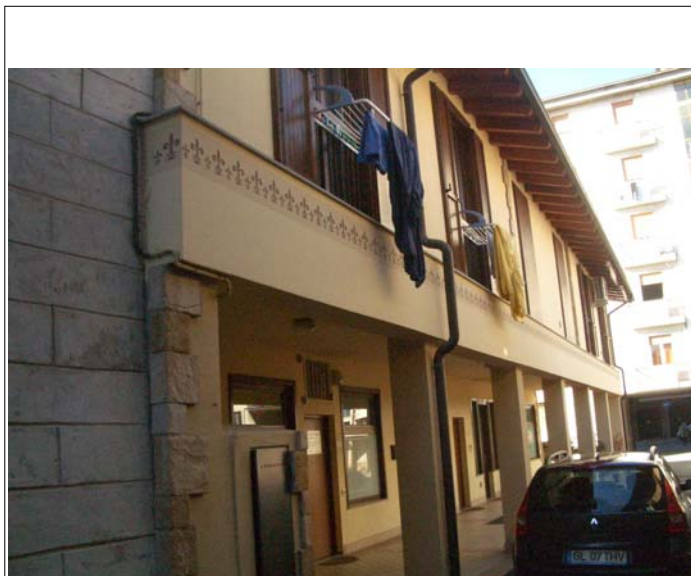
Corpo A fronte sul vicolo
