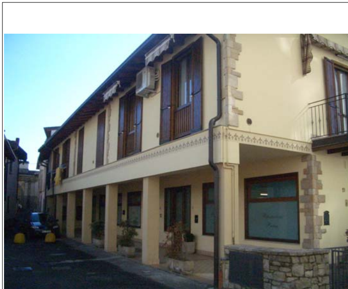
Corpo A fronte sul vicolo
