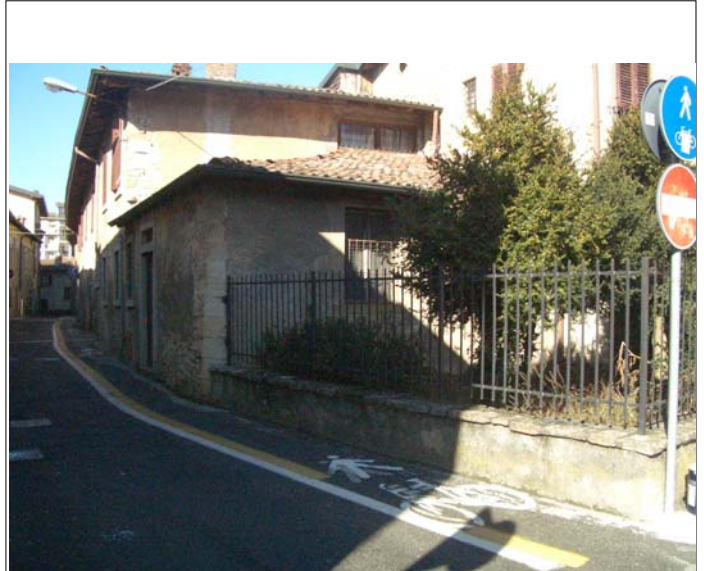
Corpo G scorcio su via Pintor
