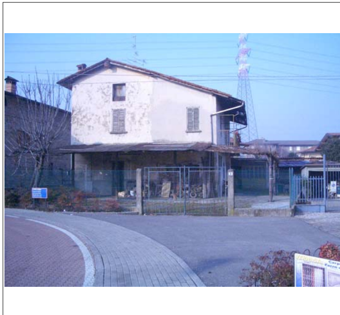
Corpo B prospetto est e costruzioni accessorie
