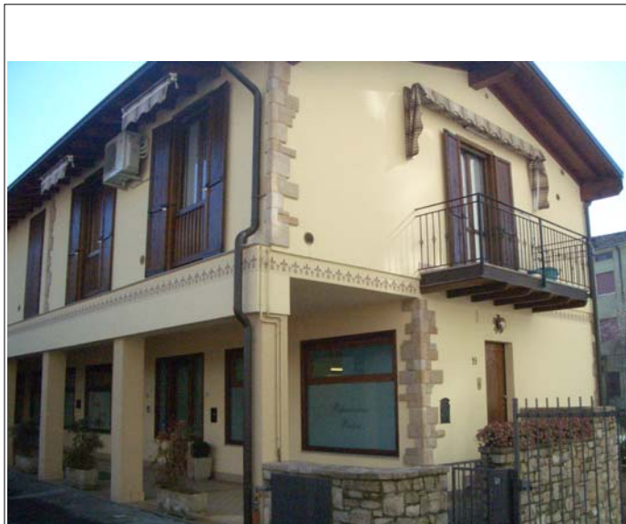
Corpo A fronte ovest
