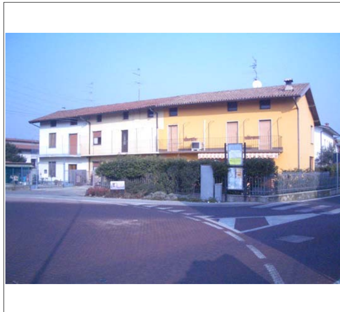
Corpo A fronte su strada
