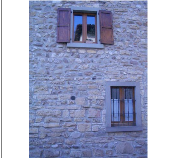
Corpo B particolare muratura e finestre
