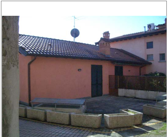
Corpo C fronte nord-ovest
