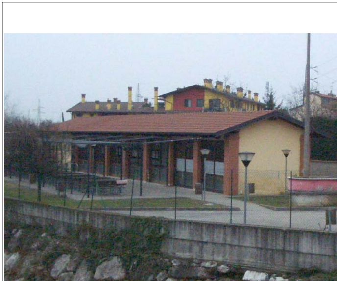
Corpo A l'edificio visto da nord
