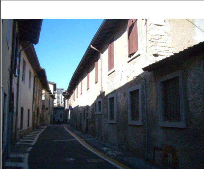
Corpo G scorcio su via Pintor
