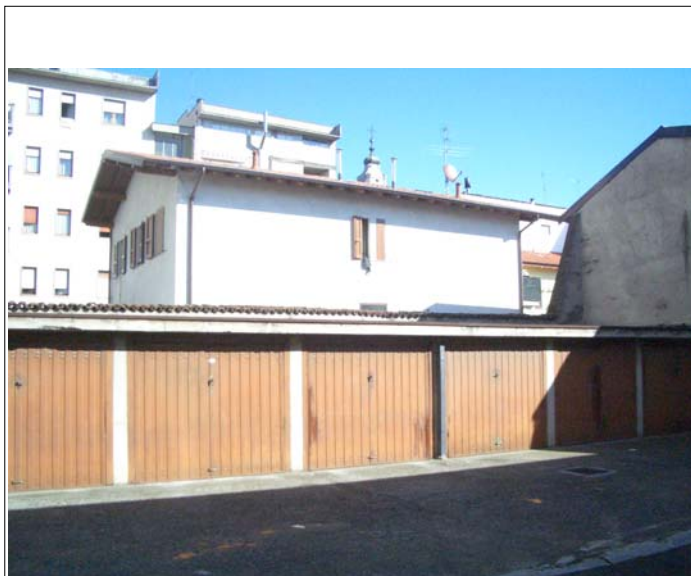
Corpo A fronte sud
