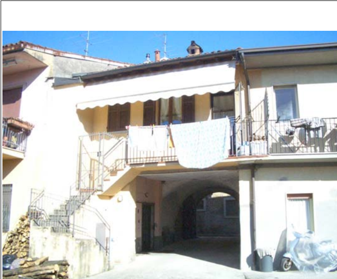
Corpo A dal cortile interno
