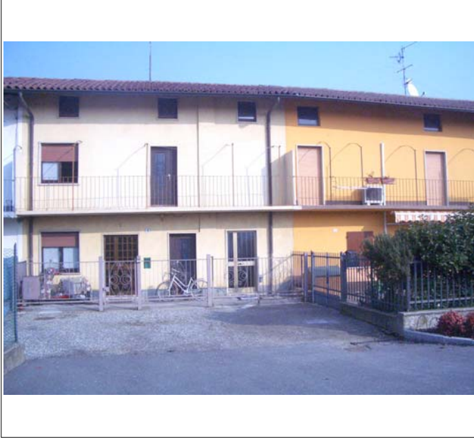
Corpo A fronte su strada
