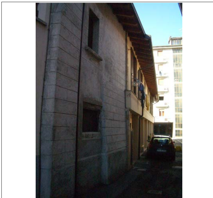
Corpo C fronte sul vicolo
