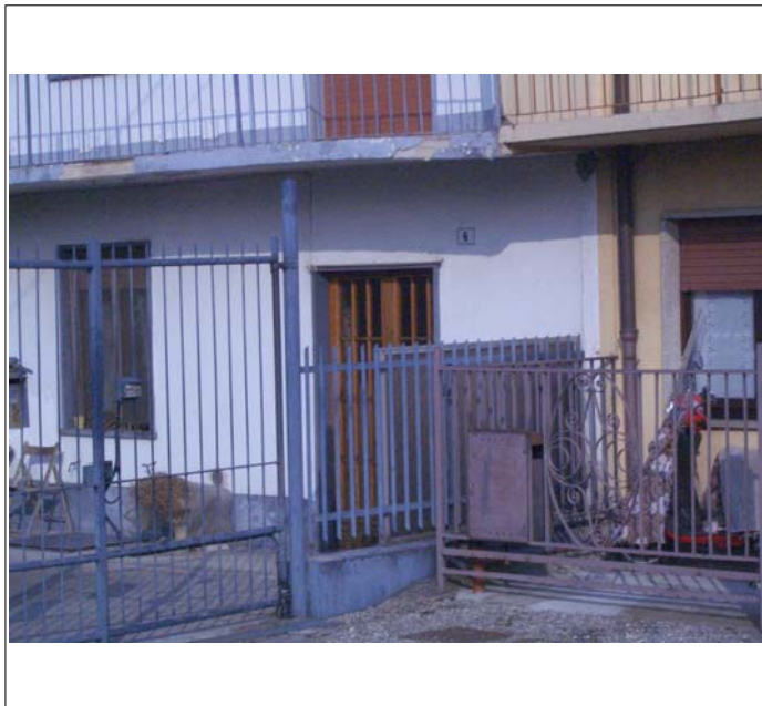
Corpo A l'ingresso
