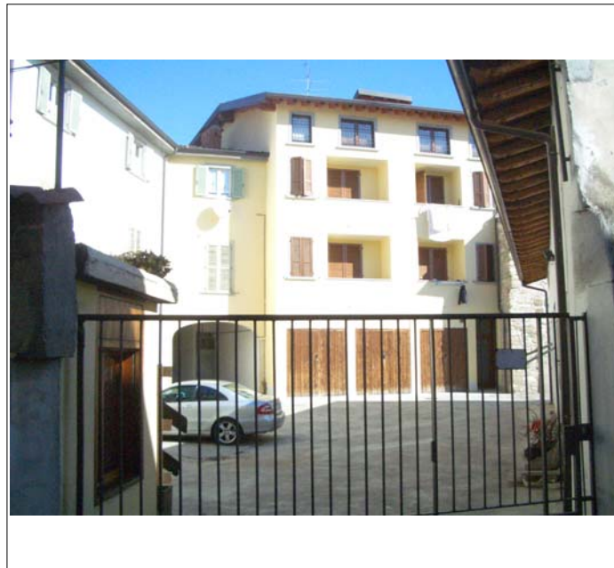
Corpo A facciata interna
