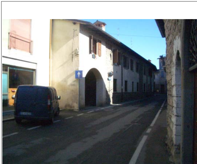
Corpo A fronte su strada
