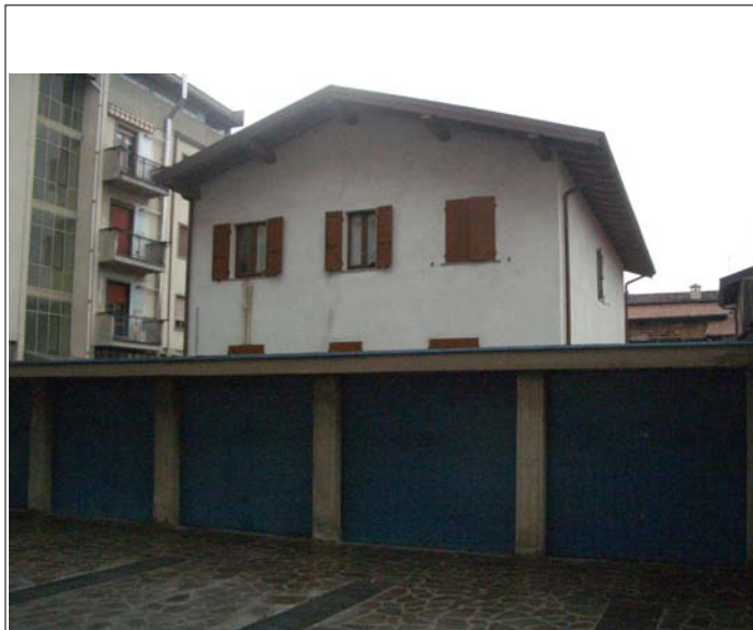
Corpo A fronte ovest
