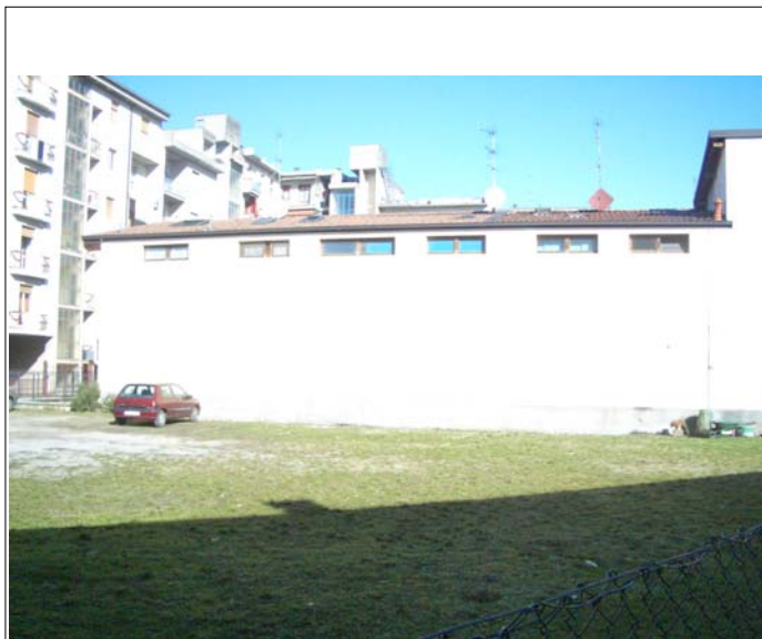
Corpo A retro (fronte sud)
