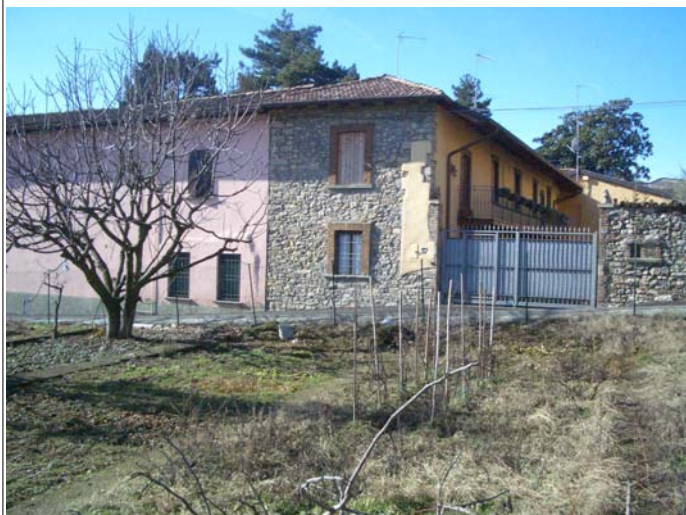
Corpo A fronte nord-est
