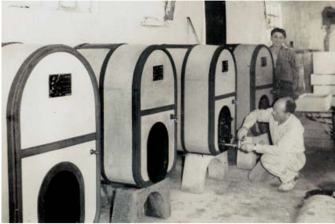
1956: Severo Testa e il collaudo delle prime botti di cemento, brevettate
