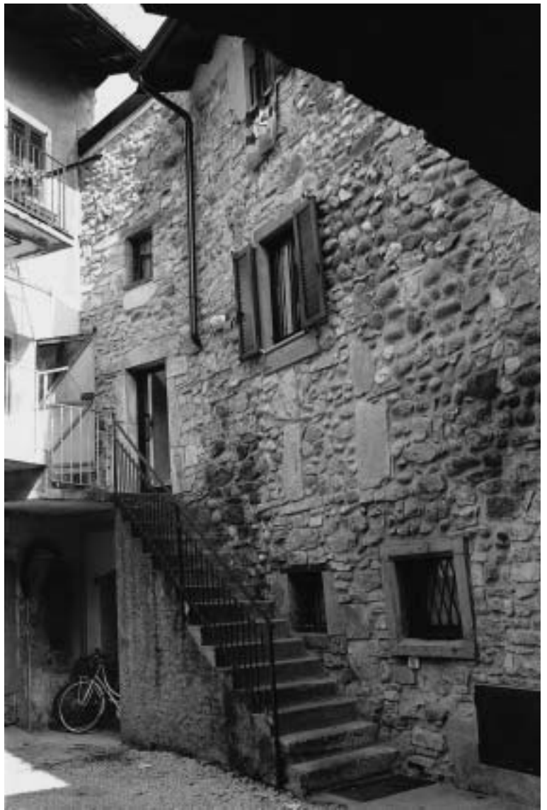
Cortile interno di via Regina Margherita
