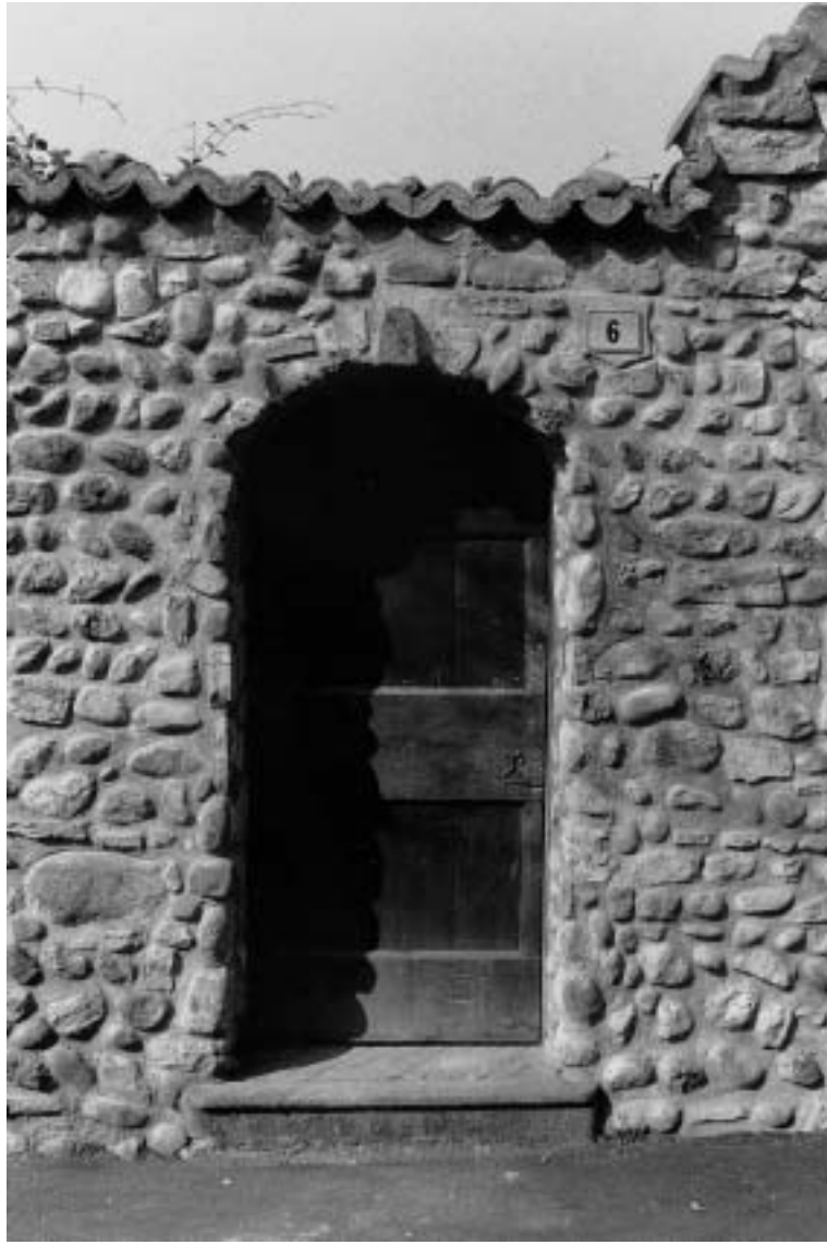
Via Martina: particolare del muro di confine, costruito con "borlanti" di fiume
