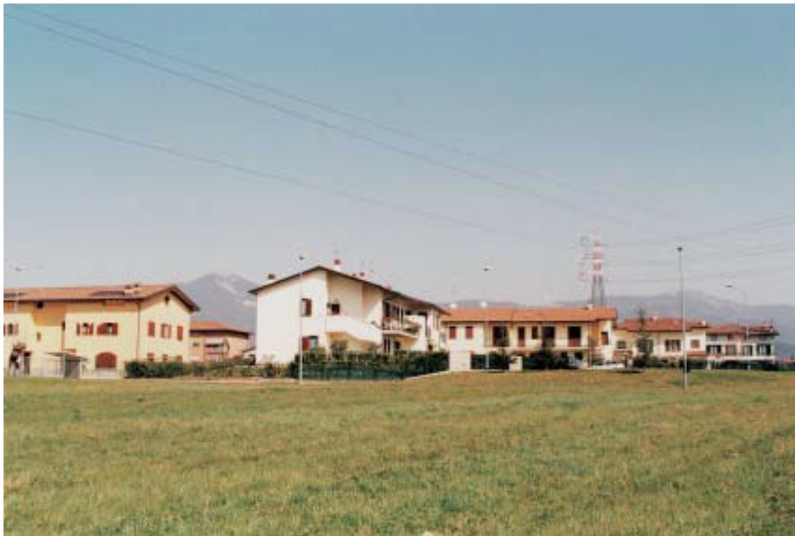
Nuove costruzioni in via Cotta. Sullo sfondo, l'onnipresente monte Misma
