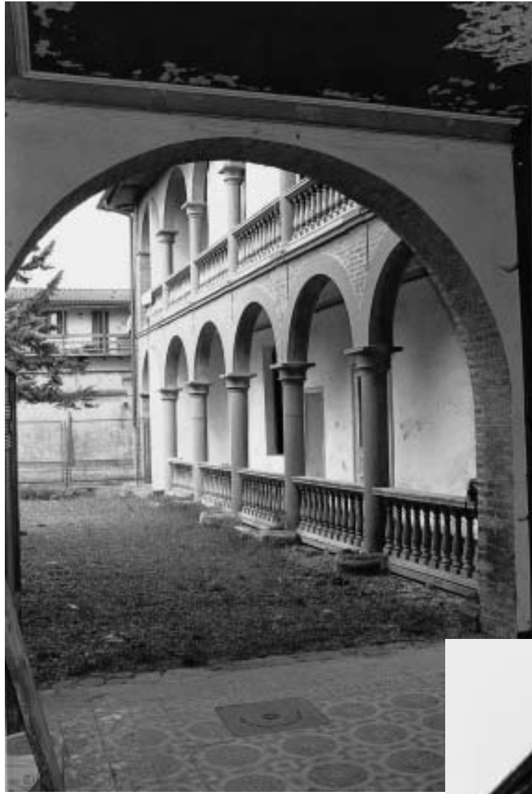
"Castel Riposo": colonnato visto dal portico dell'entrata di piazza Europa
