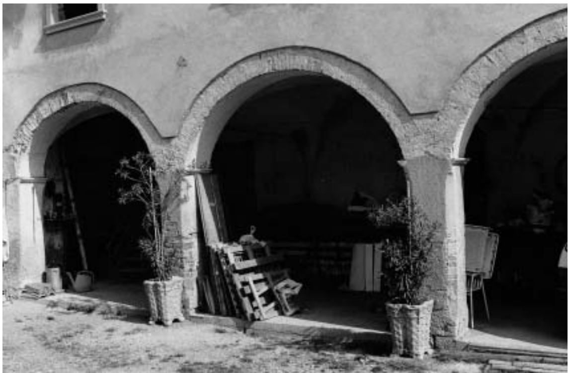
Piazza Europa: casa Ferrarini dopo la ristrutturazione della facciata, particolare dei portici 45
