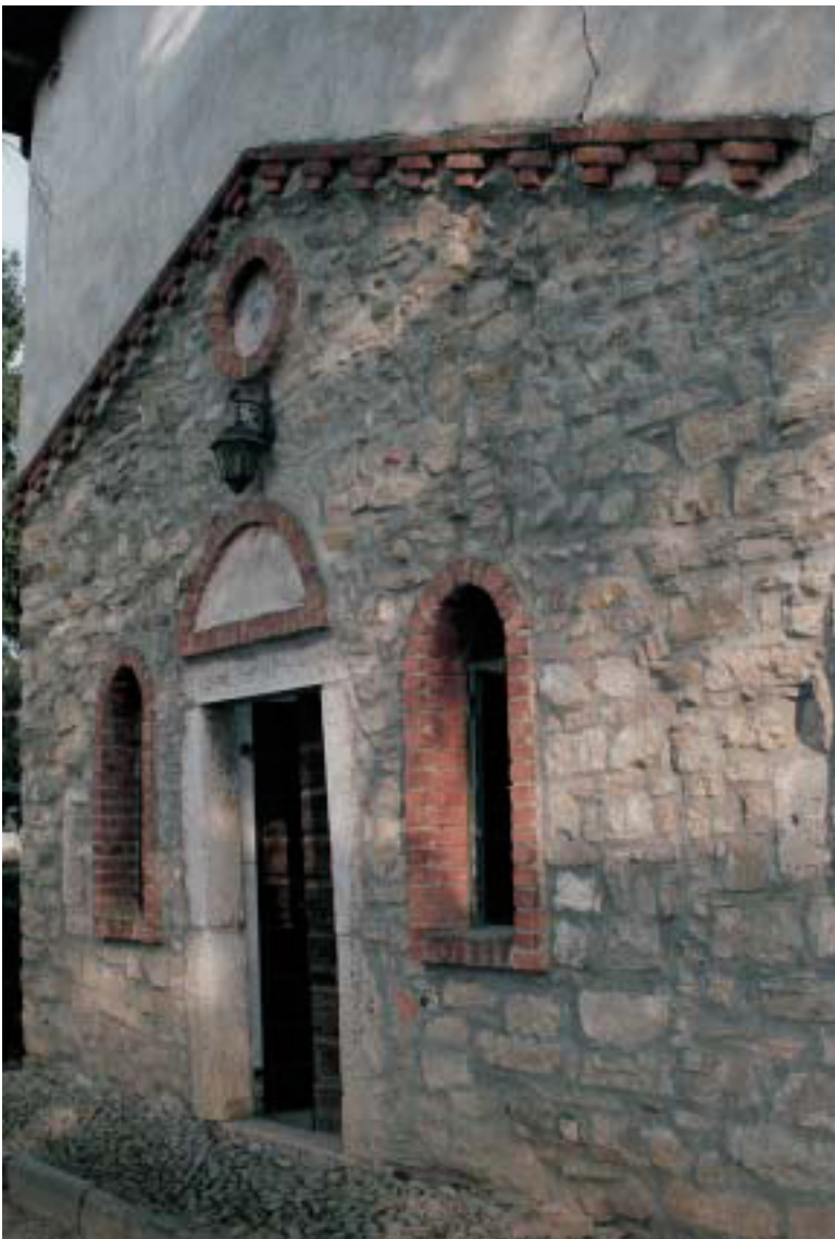
Chiesa di San Felice facciata
