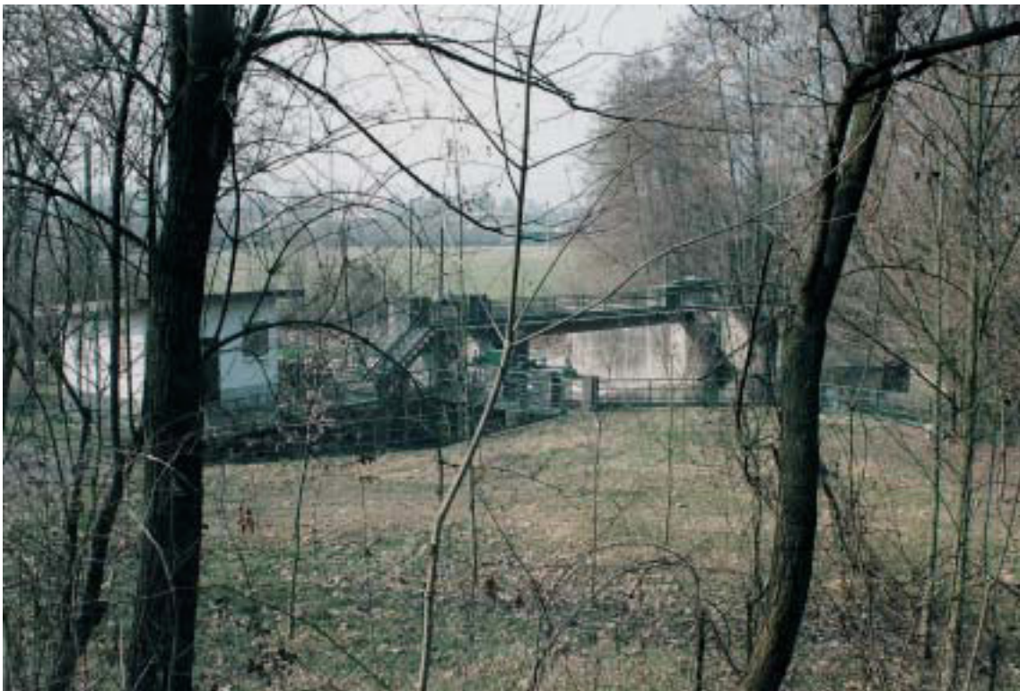
Fiume Cherio. Bocca di presa della roggia Bolgara
