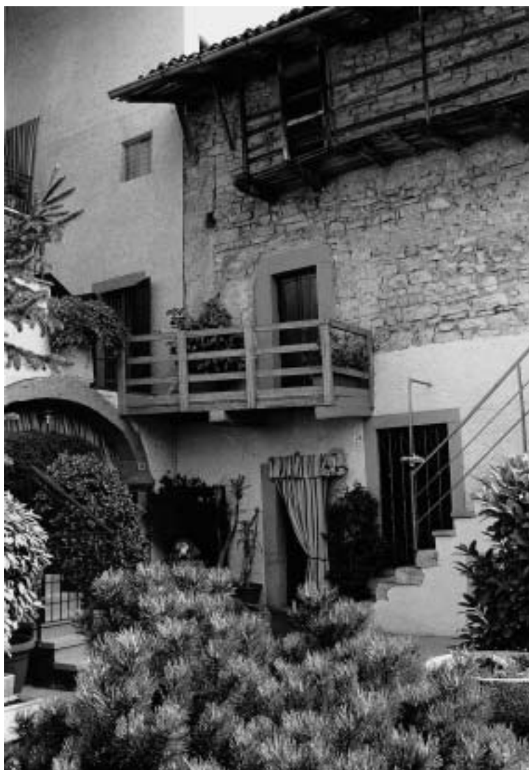
Via Vimercati Sozzi: casa Manenti, con le vecchie ringhiere. (Cortile interno)
