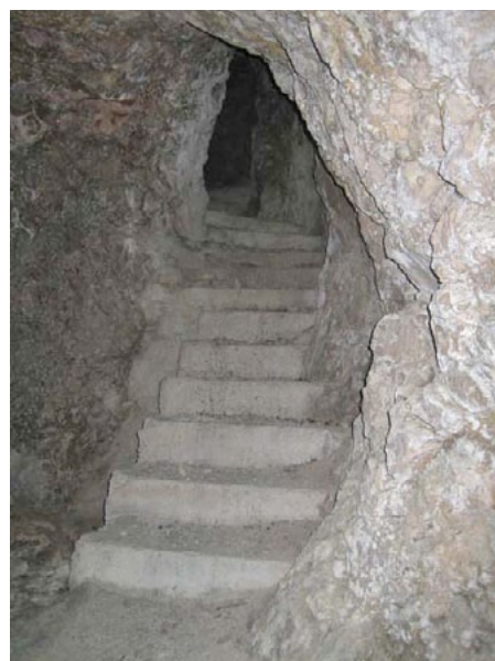
Forte Pozzacchio, interno.
