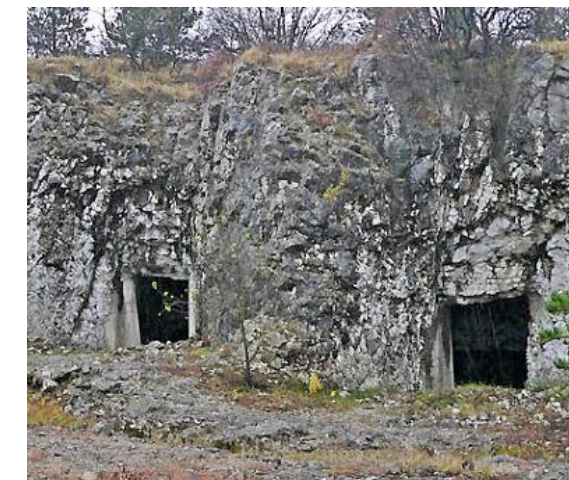
Finestroni delle cannoniere visti dall'esterno.
