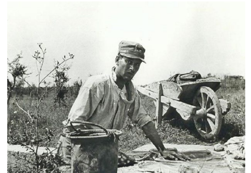
Operaio civile al lavoro sul fronte del basso Isonzo.
