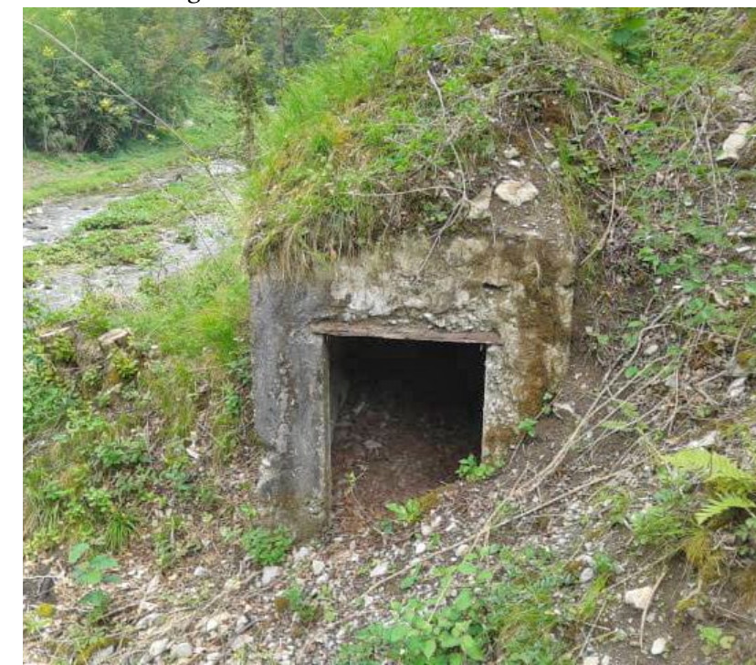
Trincea a Cimego.
